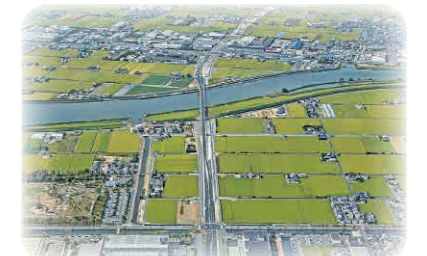
笹ヶ瀬令和橋・外環状線整備の整備
